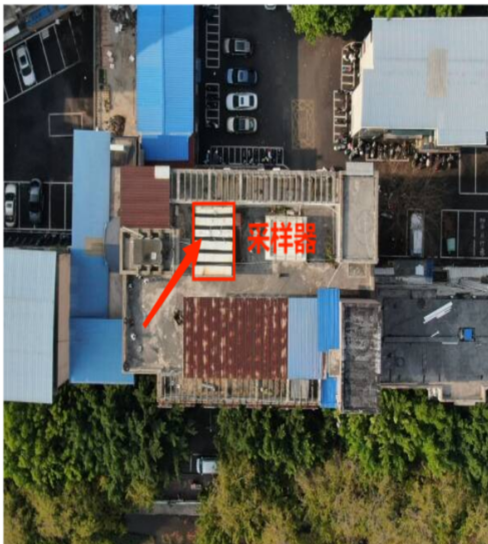
图 1-3：无人机航拍站点采样器位置
