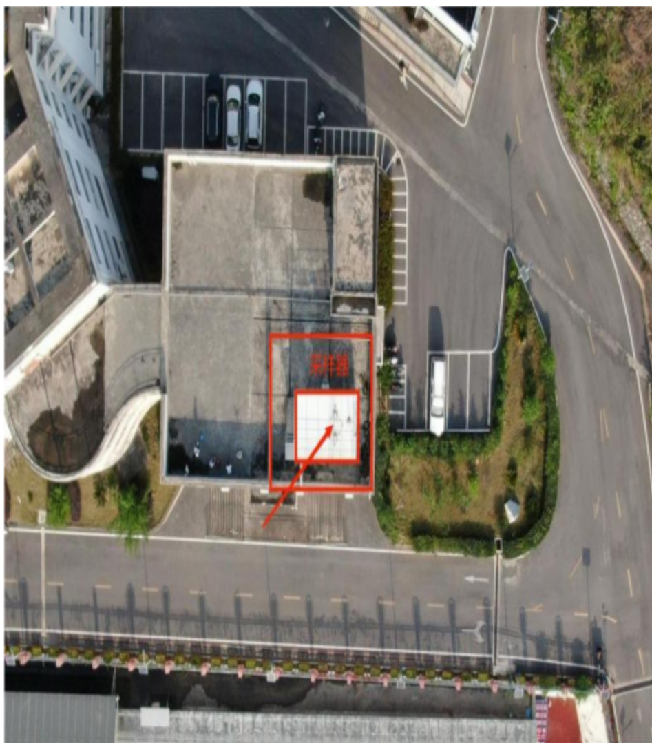
图 2-3：无人机航拍站点采样器位置
