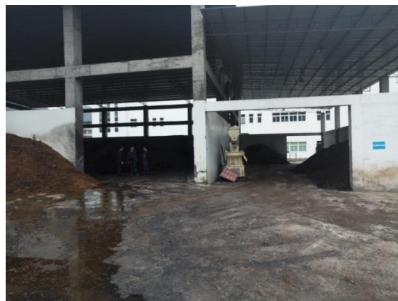
药渣、煤渣仓库
